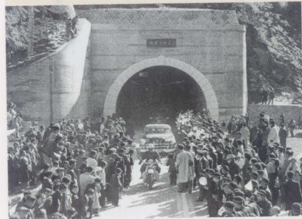
新笹子トンネル開通
