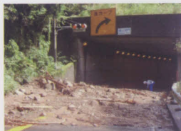
写真：土砂崩れにより寸断された国道52号(身延町万沢)
