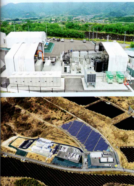
米倉山でグリーン水素を製造するP2Gシステム
