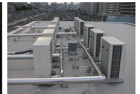
東京メトロ様 空調機更新工事
