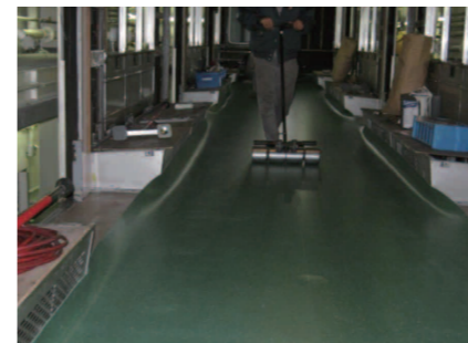
客室内床張替
