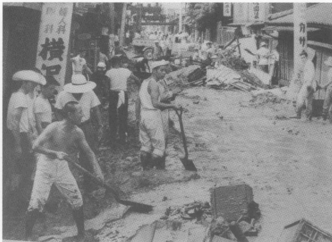
昭和41年7月22日、甲府市北部に集中豪雨があり横沢町（朝日3丁目）の相川がはん乱、濁流が住宅街を襲い死傷者58人を出した。復旧作業をする市民たち。（『山梨百年』より）
