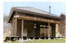
2014年10月 2号棟完成
