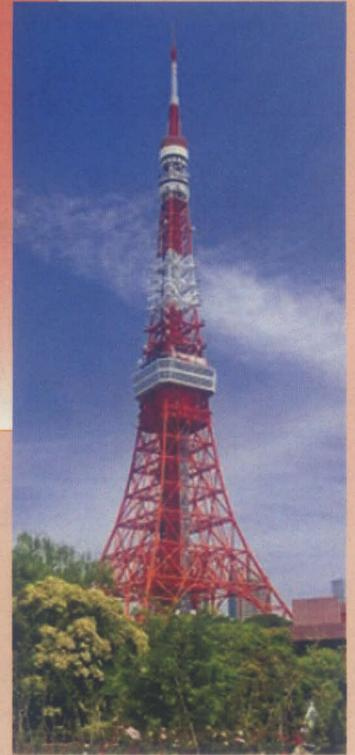
1958年(昭和33年)に竣工。高さ333m、エッフェル塔よりも高いにもかかわらず、内藤多仲の構造計算によりエッフェル塔の半分以下の鉄骨重量で建設が可能になった。
