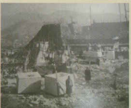
建設中の謝恩碑
