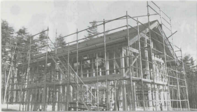
⑤ 屋根葺き、窓サッシ取り付け
