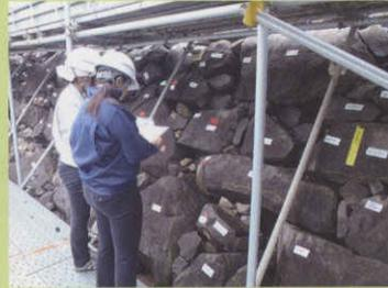
現場では、すべての石材を点検、記録し、補修方法の判断材料とします。
