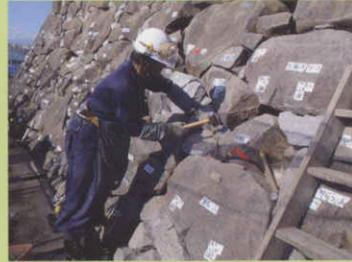
作業では古い材料をなるべく使い、歴史的景観に違和感がなく、落石等が生じないように施工しています。
