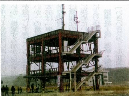
【多くの方が訪れている防災対策庁舎】
