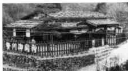
▲第4、5回(昭和2、3・1928、1929)のコース本曾街清賀川開所路付近。
