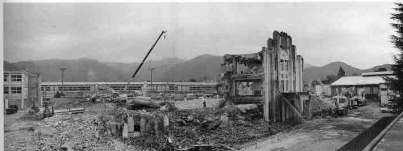
▲校舎解体！ うしろにプレハブの仮設教室が見える。(平成4年9月・1992)
