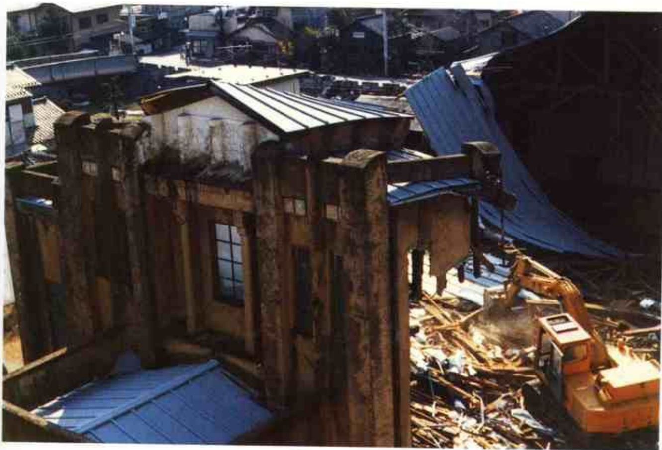
講堂の解体作業
