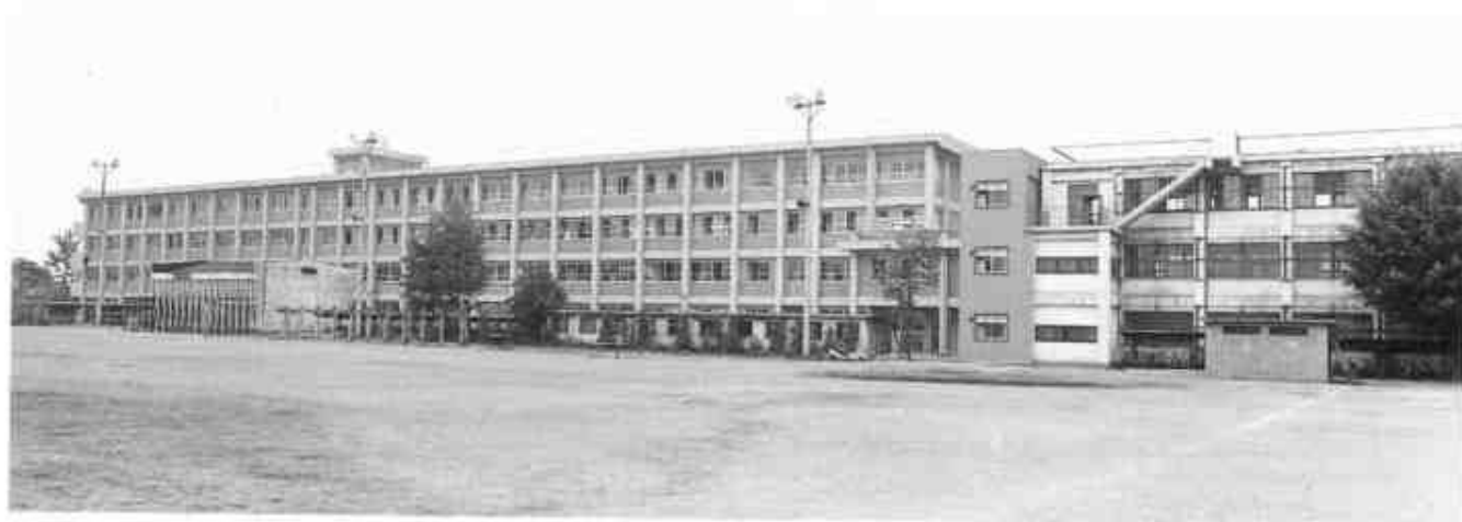
新校舎北館全景
