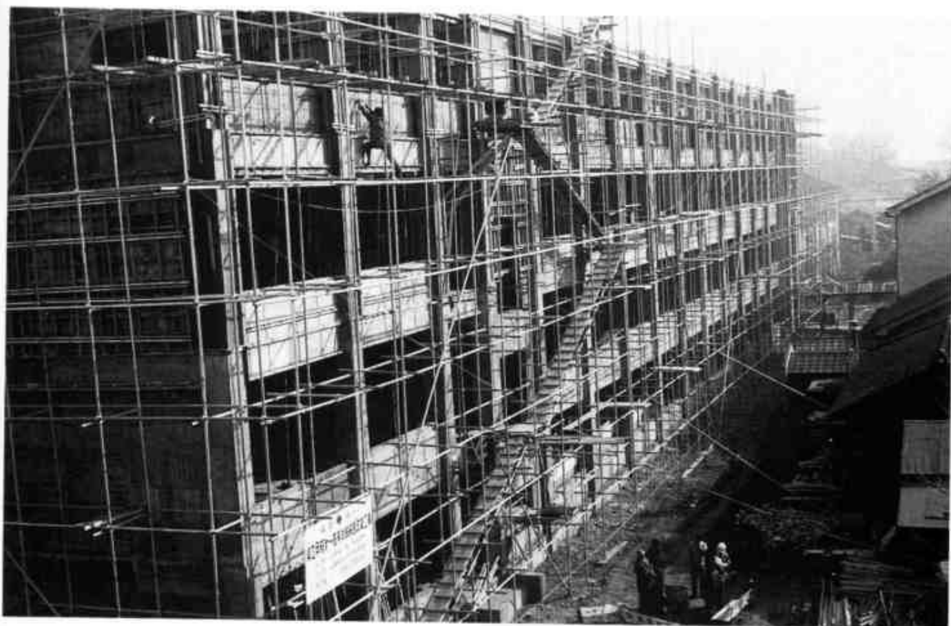
工事中の新校舎
