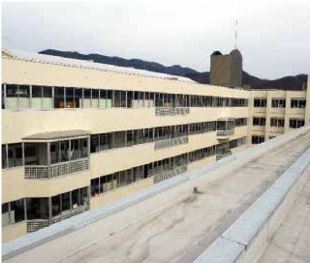
屋上から見る校舎
