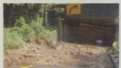
土砂崩れにより寸断された国道52号(2014年10月4日)
