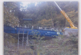
準備工事施工状況
