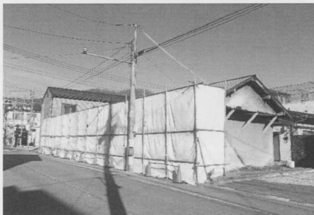
解体前（上）と解体中の長屋・旧整形外科
