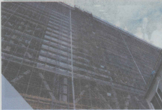
建築中の巨大物流センター
