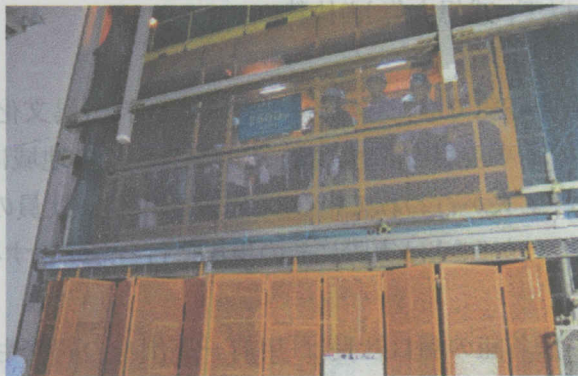
作業用エレベーターに興奮
