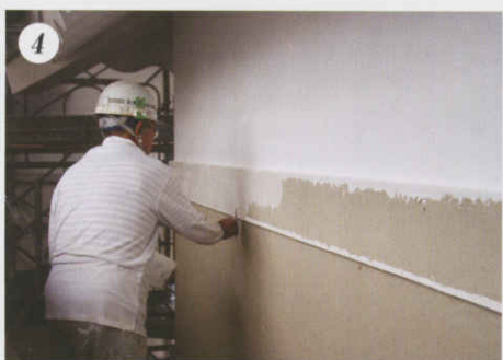
4 左官工事の最終工程・上塗り。斑がないよう素早く丁寧に仕上げられる。
