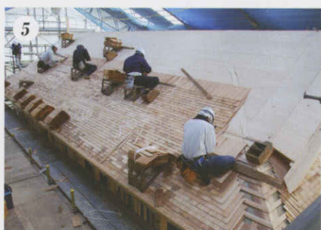
5 屋根瓦の下地となる土居葺き。薄い杉板を竹釘で均等に貼っていく。
