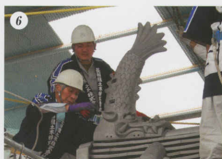
6 城内の出土品を参考に復元した鯨瓦を、慎重に大棟に載せる。
