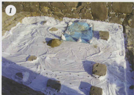
1 工事は、発掘調査で検出された江戸時代の遺構面や、礎石の保護から始まる。
