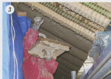
3 軒裏のきれいな波線は、左官職人が手作業で壁土をつけ形作る。
